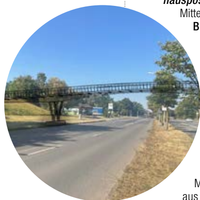
Foto: IB Brückenköpfe
