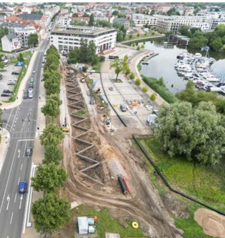
*Der Blick aus der Vogelperspektive zeigt die zickzackförmige Konstruktion, welche auch die neue Leitung in dem schwierigen Terrain aufnehmen wird*
