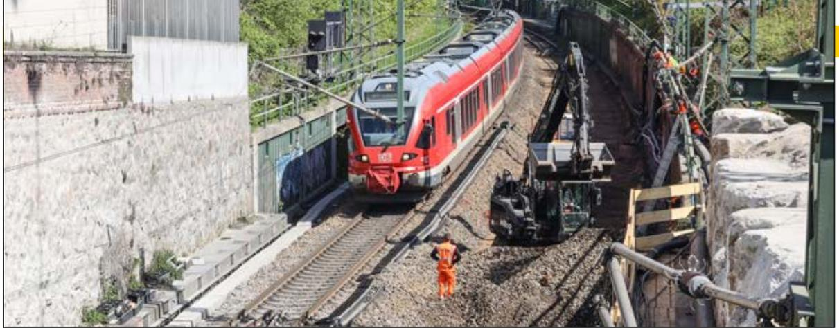
Nachdem der Brückenüberbau und die Widerlager entfernt worden sind, laufen jetzt die Arbeiten im Gleisbereich des Bauwerkes Fotos: mp
