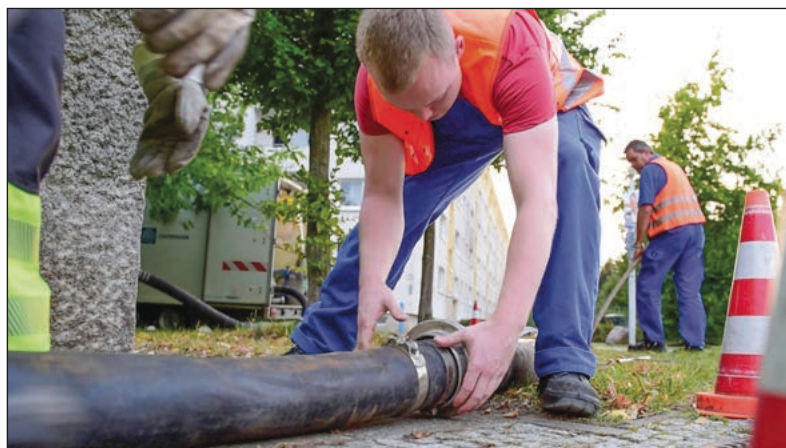
Mit Spezialtechnik wurden die Trinkwasserleitungen gereinigt
