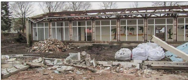
Nachdem alle gefahrstoffbelasteten Bauelemente aufwendig entfernt wurden, steht von dem Gebäude nur noch die Hülle. Diese kann jetzt mit Baggern abgebrochen werden
