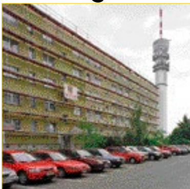
Erstmalig: Mieter mußten trotz Bauarbeiten nicht ausziehen Foto: maxpress
