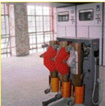
Innenansichten: Bei Kabelschäden sorgen Schaltanlagen für Sicherheit.
