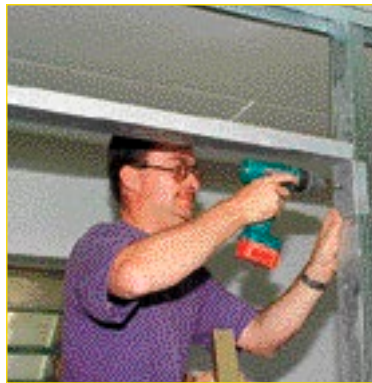
Zügiger Innenausbau Foto: maxpress
