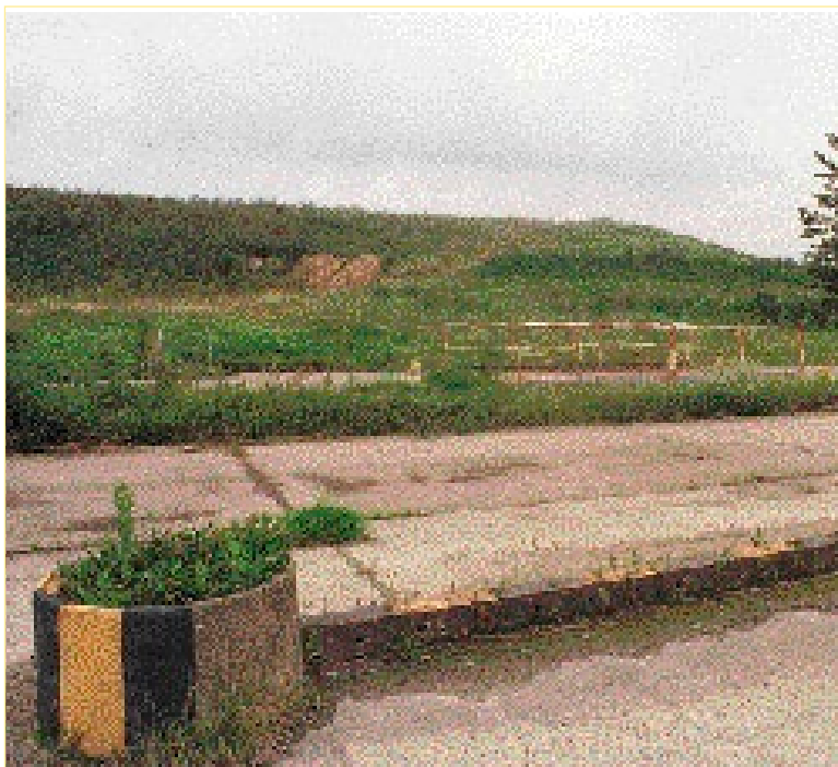
Zählt zu einer der zu übernehmenden Aufgaben, die auf die neue Besitz-GmbH zukommen werden: Die Nachsorge der Deponie Stralendorf
