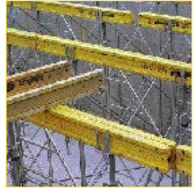
Gerüstzauber: Vor Schließung der Tanks müssen die Gerüste fallen
