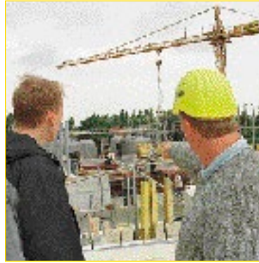
Baustellen-Besprechung: Aussicht vom ersten Becken auf das Wasserwerk
