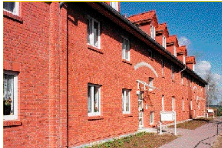
Der erste Bauabschnitt am Ziegelhof wurde bezogen
