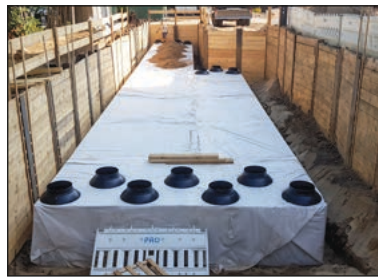
Für ein Krankenhaus planen I-TEG-Mitarbeiter auch die Regenrückhaltung
