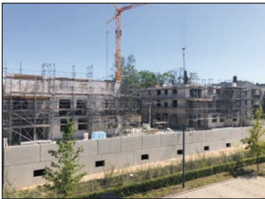
Die Bauarbeiten gehen voran
