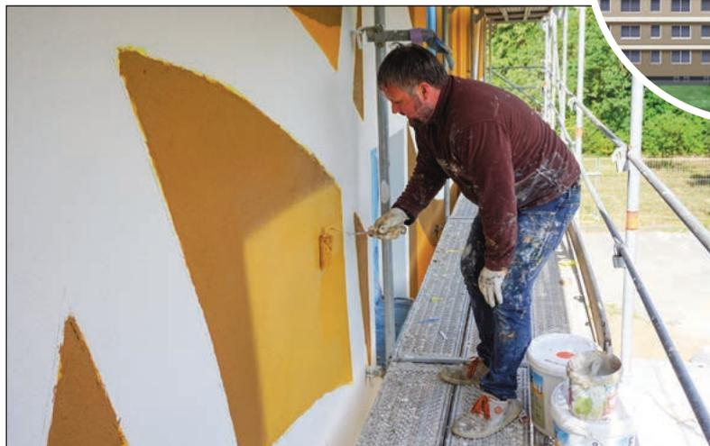
Die Maler bringen mit Hilfe von speziellen Schablonen die Farbe an die Fassade des Wohnhauses. Am Ende entsteht ein dynamischer 3D-Effekt
