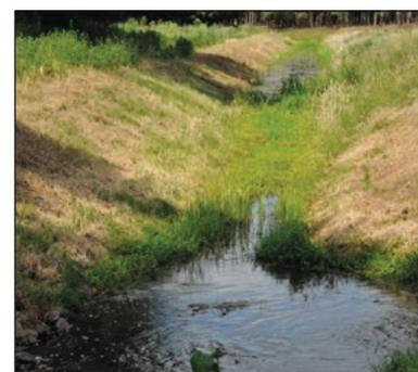
Gereinigtes Abwasser gelangt über ein Rohr- und Grabensystem in den natürlichen Kreislauf. Zur Gewährleistung des Abflusses sind regelmäßige Entkrautungen der Gräben nötig, in denen sich auch Wasserbewohner wohl fühlen. Fotos: maxpress/ba
