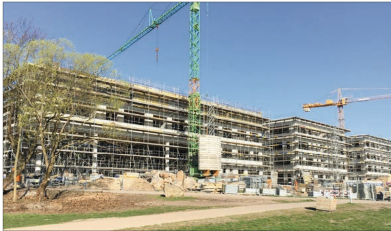
Noch ist die neue Berufsschule Technik eine Baustelle. Im Sommer 2021 sollen hier dann 1.700 Berufsschüler einziehen Foto: Zentrales Gebäudemanagement
