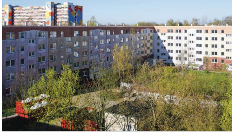
Die beiden Wohnblöcke in der Edgar-Bennert-Straße werden seit Februar umfangreich modernisiert. Es entstehen 90 attraktive Zwei- bis Vierraumwohnungen Fotos: WGS
