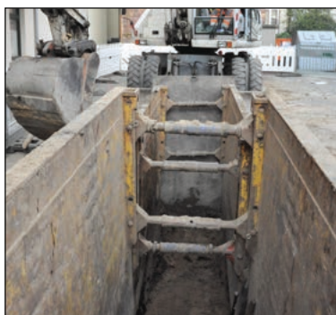
Die Abwasserleitungen werden in 4,50 Metern Tiefe verlegt
