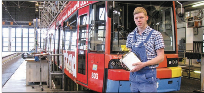
Auszubildender Lucas Sorgatz aus Uelitz installiert Antennen für das neue city.WLAN in Schwerins Straßenbahnen. Ab Juli wird das öffentliche Netz nutzbar sein Foto: SWS
