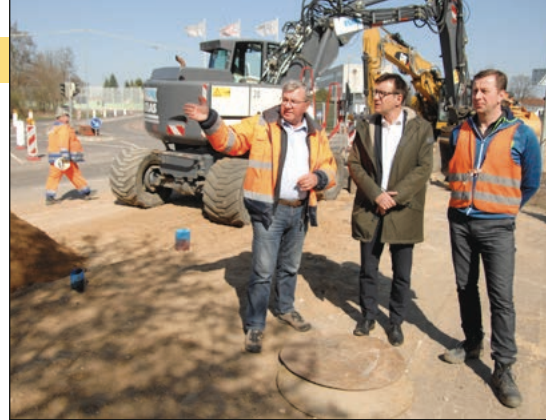
Armin Nowak (l.) und Thomas Maync (r.) zeigen Bernd Nottebaum den Baufortschritt in der Rogahner Straße Foto: maxpress
