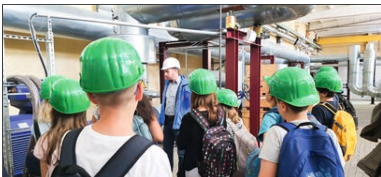
Wie Fernwärme funktioniert, konnten sich Schüler im Heizkraftwerk ansehen
