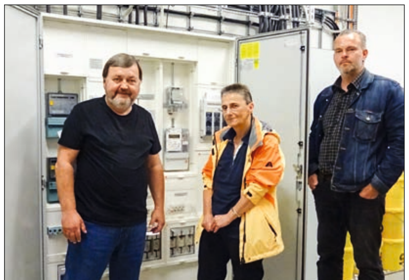
V.l.: Wilfried Berteit, Angret Oswald und Jörg Schwenson prüfen die technischen Anlagen Fotos: Zentrales Gebäudemanagement
