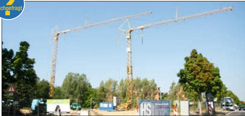
Im Elleried werden jetzt nach und nach auch die letzten Baulücken geschlossen. So auch hier an der Ecke zum Eckdrift Foto: maxpress
