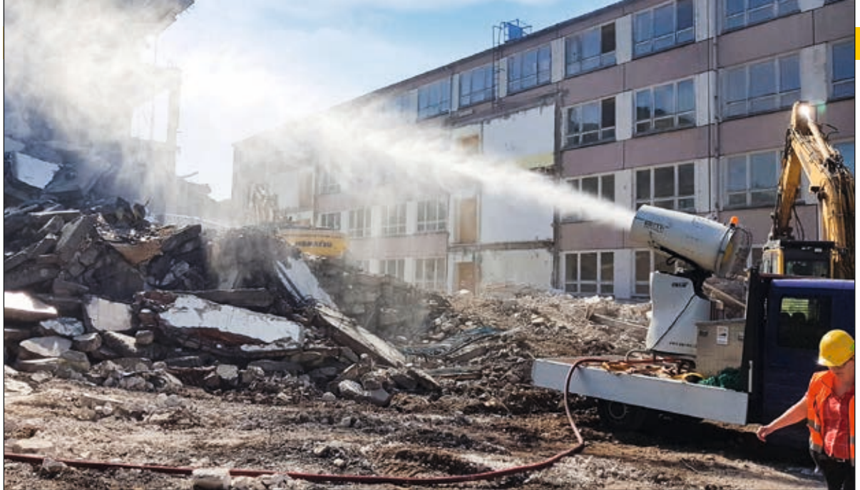
Bei den Abrissarbeiten an der Schule in der Weststadt kommt derzeit eine Schneekanone zum Einsatz
