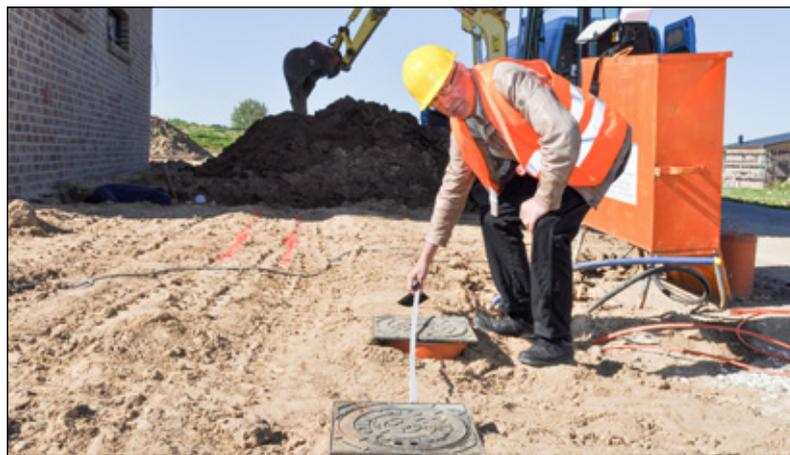
Lothar Jäger prüft die korrekte Installation der Anschlüsse für die Schmutz- und Regenwasserentsorgung bei einem Neubau in Friedrichsthal *Fotos: ba*
