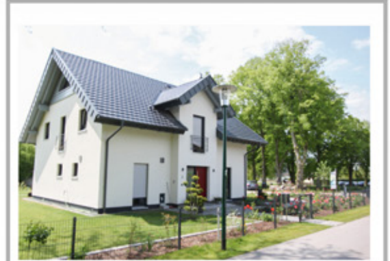
SB Beratungszentrum Cambs bei Schwerin
