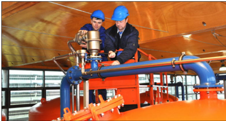
Martin Linsel und Jens Schumann warten einen Filter im Wasserwerk Foto: maxpress/ba
