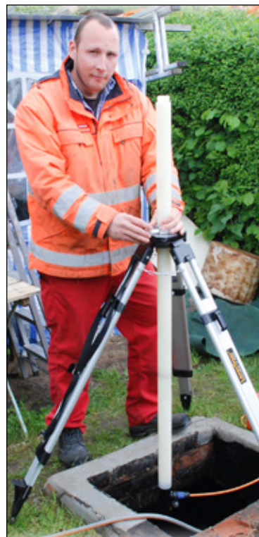
Zum Schutz der Umwelt müssen alle Gruben auf ihre Dichtigkeit geprüft werden Foto: maxpress
