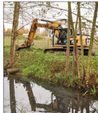
Mit schwerer Technik wurde die Zuwegung zum umgestürzten Baum hergestellt Fotos: am/ba
