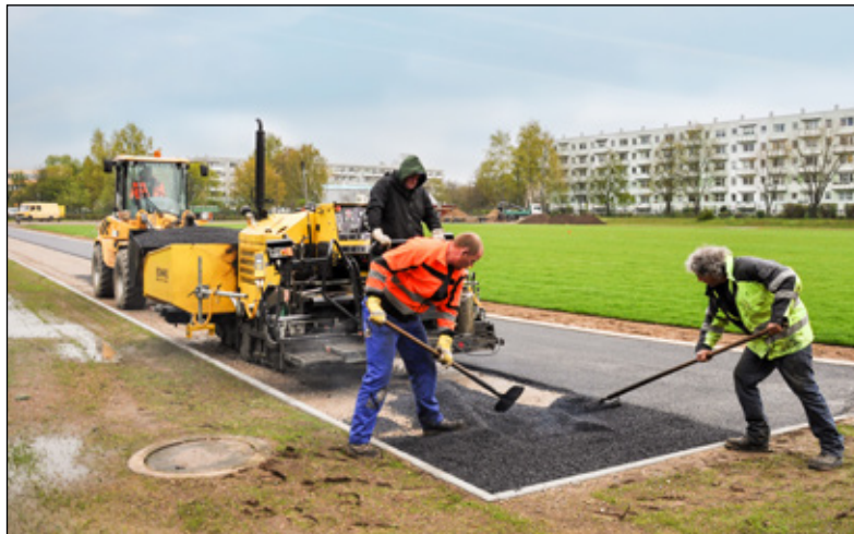
Die Laufbahnen auf dem Sportplatz in der Weststadt wurden asphaltiert und erhalten eine Kunststoffoberfläche Foto: ba
