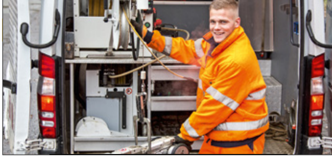
Azubi Sebastian Pautzke bereitet eine Kanalbefahrung vor
