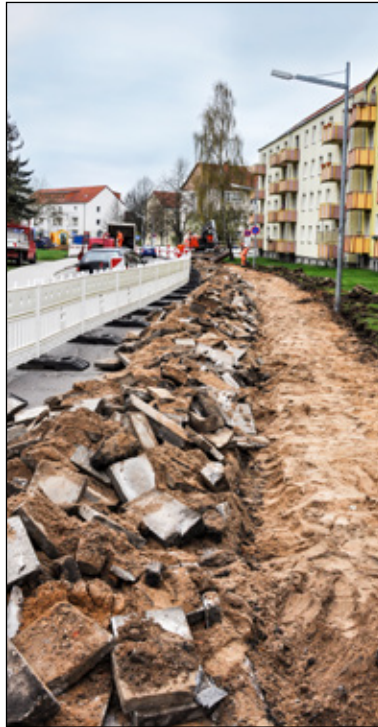
In der Weststadt ist graues Rechteckpflaster zur Instandsetzung der Fußwege verlegt worden Foto: ba
