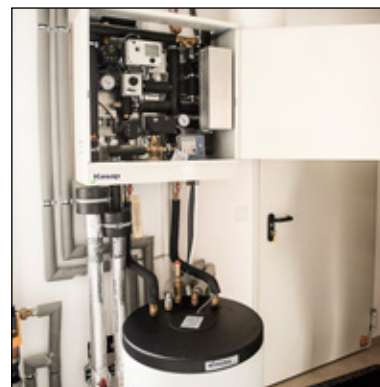
Eine Fernwärmestation mit Warmwasserspeicher
