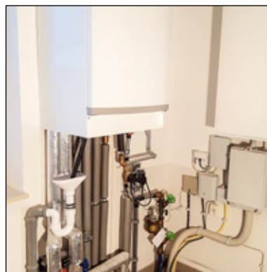
Eine Fernwärme-Station im Durchflussprinzip Fotos: Stadtwerke
