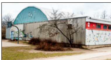
Die alte Einfeldhalle der Grundschule Lankow wird abgerissen und ersetzt
