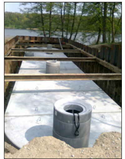
Mit Hilfe schwerer Technik wurden Bauteile für die insgesamt sechs unterirdischen Regenwasserbehandlungsanlagen installiert Fotos: WAG
