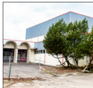
Die Halle am Fernsehturm
