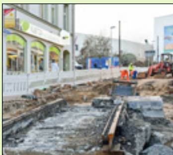
Die Bauarbeiten liegen voll im Plan
