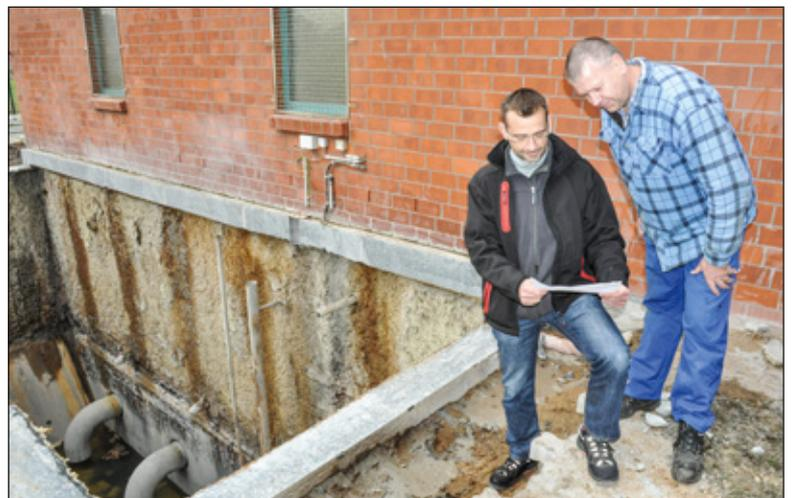
Gegenwärtig laufen Sanierungsarbeiten am Abwasserpumpwerk Plater Straße. Durch die Erneuerung des Sammelbeckens wird weiteren Korrosionsschäden vorgebeugt. Fotos: ba
