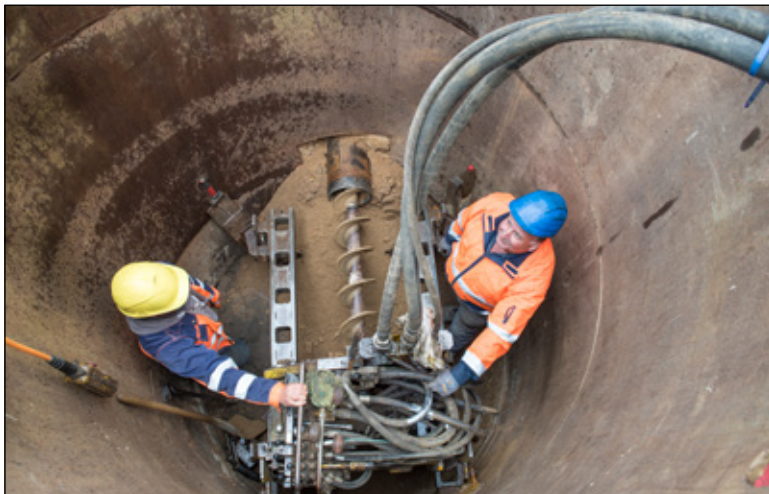
Unterirdisch wird das Rohr vorgetrieben
