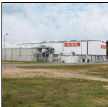
In der SAS-Biogasanlage entstehen aus biologischen Reststoffen Strom und Wärme
