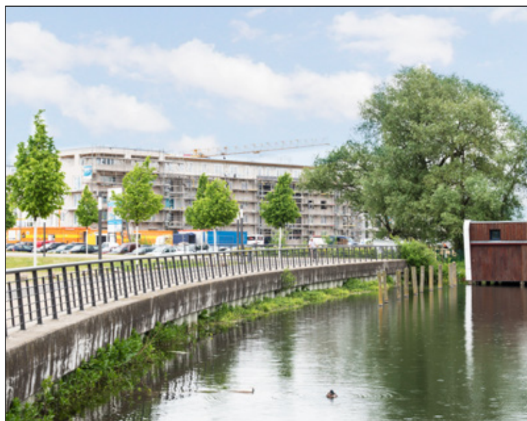
Blick auf die Baustelle an den Waisengärten aus südlicher Richtung, wo das neue Wohnquartier entstehen wird Foto: maxpress/jl
