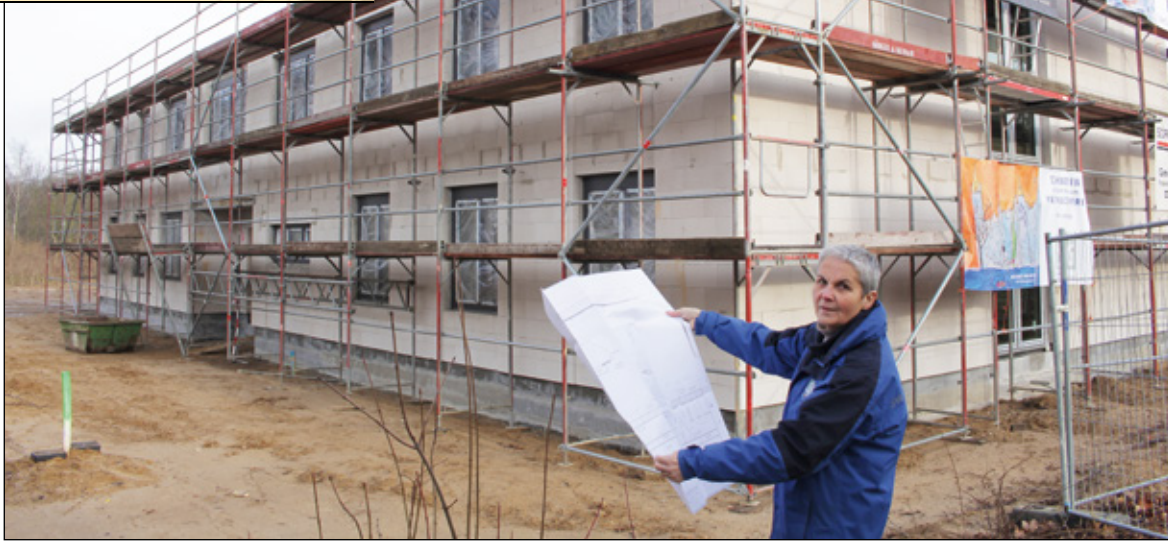
Gabriele Szymanski, Abteilungsleiterin der Hausverwaltung 2 bei der SWG, prüft den Stand der Bauarbeiten
