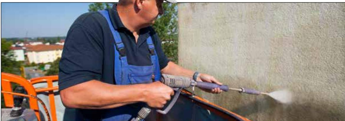
Mit Hochdruck werden die Fassaden in der von-Stauffenberg-Straße von einem Spezialisten gereinigt
