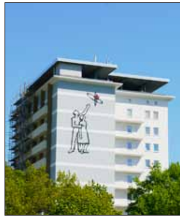
Das Hochhaus nach der Sanierung mit ebenfalls aufgearbeiteter Kunst „Mann, Frau, Sputnik“ Foto: WGS
