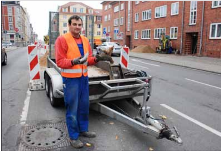
Thomas Koch zeigt einen Bleianschluss. Bis Mitte November werden die letzten Hausanschlüsse wie hier am Wittenburger Berg ausgetauscht Fotos: maxpress/ba
