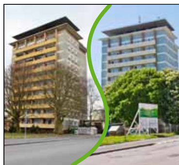
Das Hochhaus vor und nach den Sanierungsarbeiten Foto: maxpress/jk
