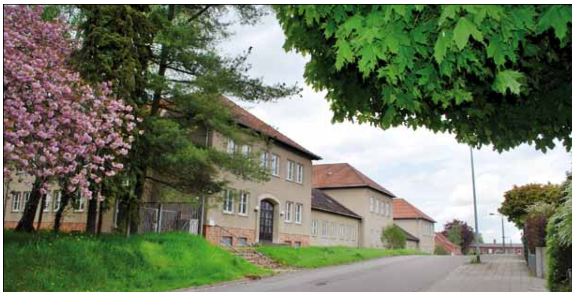
Wird modern umgebaut: die alte Postschule und das umliegende Gelände auf der Halbinsel Krösnitz. Der Umbau hat bereits begonnen. Fotos: maxpress/ai/jk/lz
