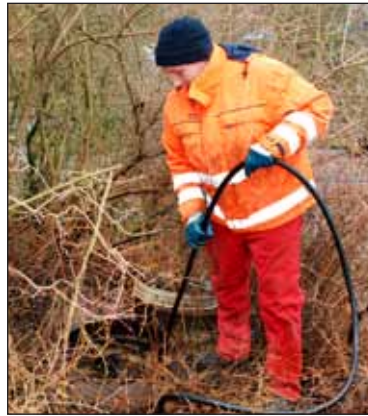
WAG-Mitarbeiter Marcel Kröger spült den schwer zugänglichen Reinigungsschacht
