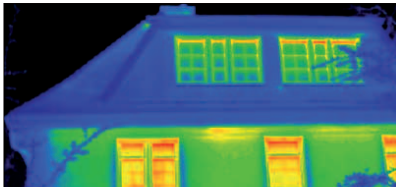
Die rötlichen Stellen im Wärmebild zeigen ganz deutlich, wo das Haus Wärme verliert und wo sich möglicherweise Baumängel befinden Foto: SWS
