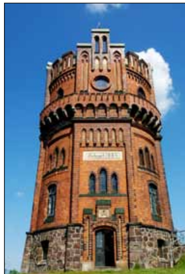
Der Neumühler Wasserturm ist für viele ein beliebtes Ausflugsziel Fotos: SAE
