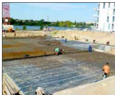
Vorbereitungen für die Grundplatte
