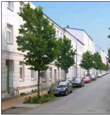
Blick in die Gartenstraße nach der Sanierung
