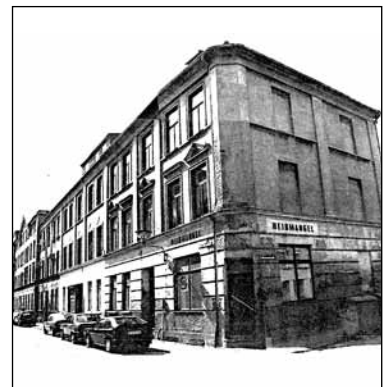
Ehemalige Kaserne in der Kleinen Wasserstraße vor der Sanierung
