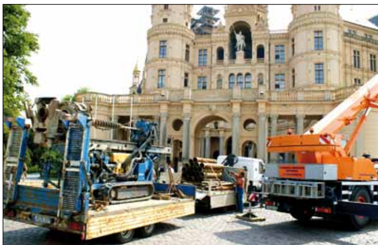
Um das Schweriner Schloss mit Fernwärme zu versorgen, werden die Leitungen mit Hilfe einer speziellen Bohrtechnik direkt unter dem Burgsee verlegt Foto: Stadtwerke
