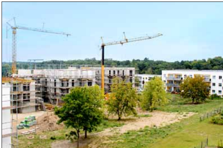
Das noch im Rohbau befindliche neue Objekt wird farblich so freundlich wie die Nachbarhäuser im Karree gestaltet Foto: maxpress/mu
