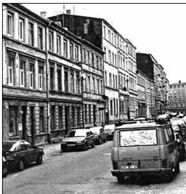
Ein Blick in die Gartenstraße vor der Sanierung
