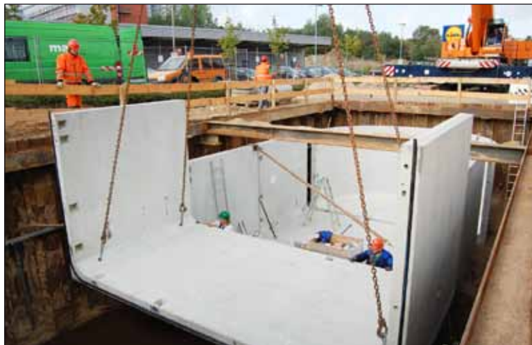
Der Bau der ersten Sedimentationsanlage ist in Kürze abgeschlossen - in dieser kann dann das Regenwasser gereinigt werden Foto: maxpress/mw
