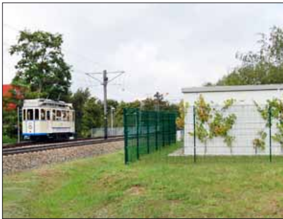
Zur Besichtigung der neuen Gleichrichterunterwerke (rechts im Bild) kamen die Gäste mit der NVS-Traditionsbahn Fotos: maxpress/mu
