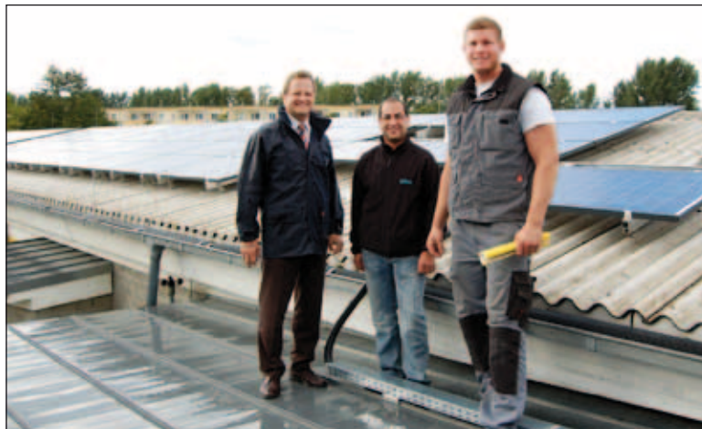
Volker Hachmann, Bereichsleiter Technik der Stadtwerke, Harut Bagli, technischer Betriebsleiter Elektro bei der Constirling GmbH, und Jan-Erik Kruse, Elektroinstallateur der Firma Balticsolar GmbH (v. l.), auf dem Dach der Körperbehindertenschule Lankow
