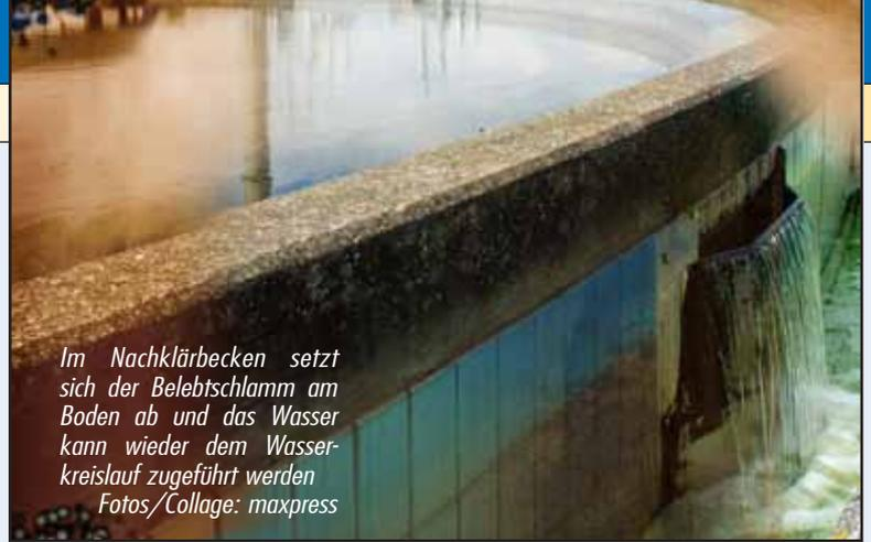
*Im Nachklärbecken setzt sich der Belebtschlamm am Boden ab und das Wasser kann wieder dem Wasserkreislauf zugeführt werden
