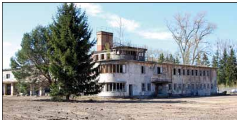
Das ehemalige Flugplatzgebäude im Gewerbegebiet Görries ist heute in einem sehr schlechten Zustand Foto: maxpress/cj
