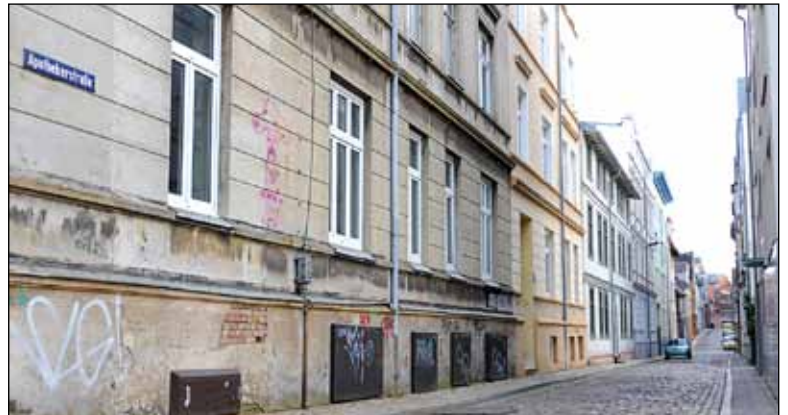
Die Erneuerung der Hausanschlüsse und Leitungen wird aufgrund der extremen Engstellen der Apothekerstraße eine Herausforderung Foto: maxpress/jk
