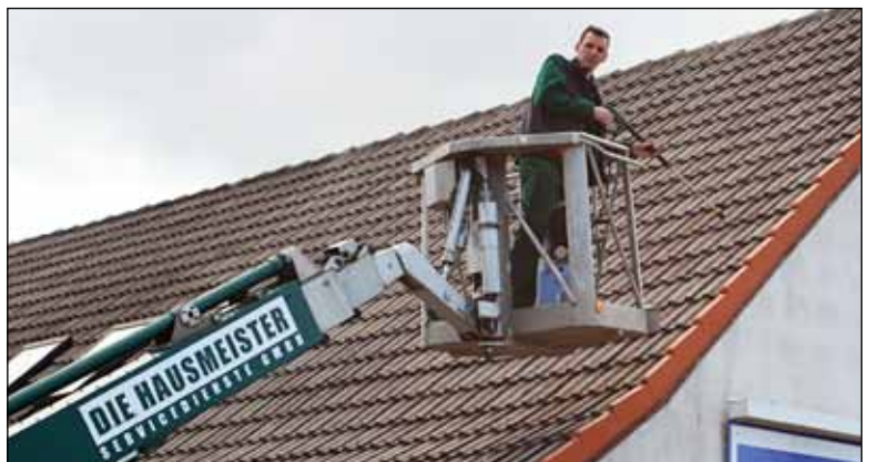
Moose und Flechten können den Dachpfannen schaden. Mit der Hebebühne kommen DIE HAUSMEISTER auf jedes Dach und können die Ablagerungen entfernen Foto: maxpress/jk
