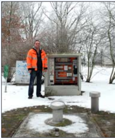
Andreas Klank, Meister Abwasserleitung, zeigt die Abdeckung mit Schaltschrank des Nebenpumpwerks am Teich in Wüstmark
