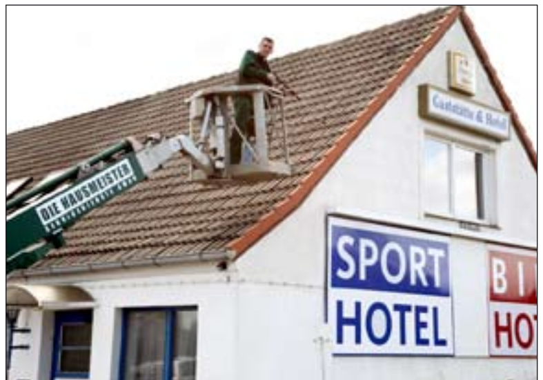
Mit einer Hebebühne kommen DIE HAUSMEISTER auch an die entlegensten Stellen - egal, ob Dachpfannen, Glasflächen oder Solarzellen gereinigt werden müssen Foto: maxpress/ks
