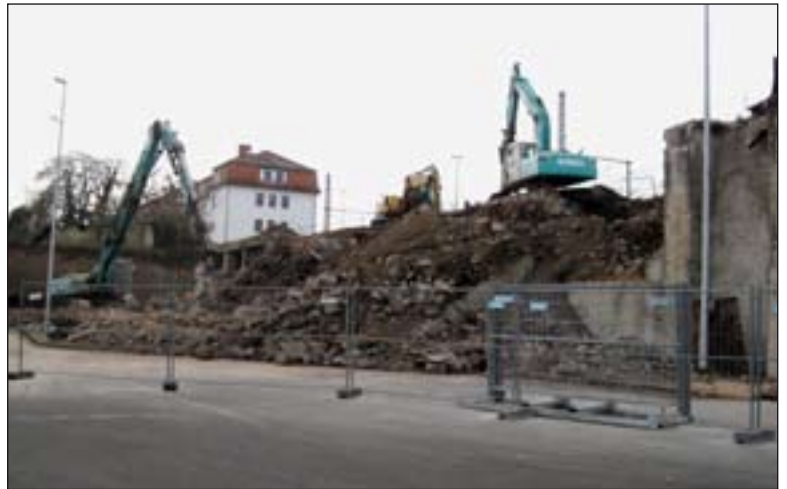
Am direkten Weg zum Hauptbahnhof wird zur Zeit noch gearbeitet
