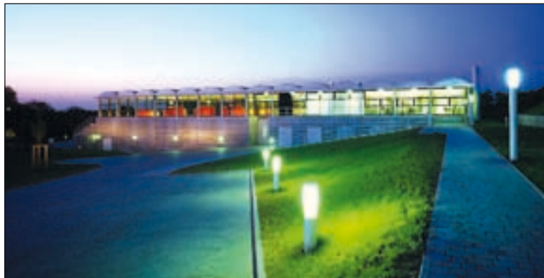
Innovative Ideen flossen in den Bau des Wasserwerkes ein. So war die freitragende Dachkonstruktion vor zehn Jahren von allen Seiten bestaunt Foto: SWS/Jörn Lehmann
