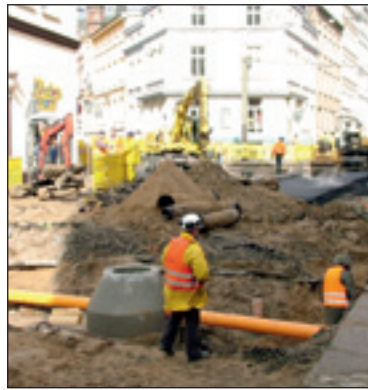
Die Bauarbeiten in der Wismarschen Straße waren eine logistische Herausforderung
