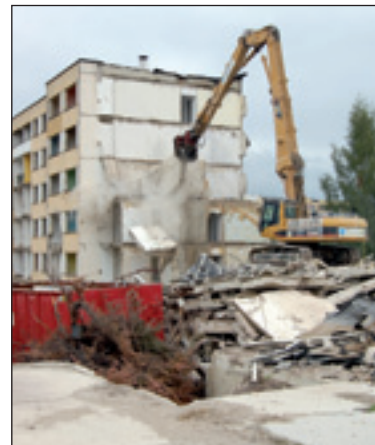
Nach umfangreicher Entkernung der Wohnblöcke wurde die Bauhülle abgetragen
