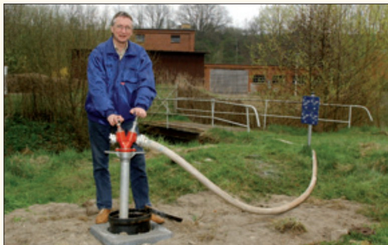
WAG-Mitarbeiter Volkhardt Zillmann spült die vom Netz getrennten Leitungen. Rückstände von Eisen und Mangan werden so restlos beseitigt Foto: max
