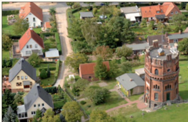
120 Jahre und immer noch gut in Schuss: Der historische Wasserturm in Neumühle dient als Trinkwasserspeicher und zum Druckausgleich Foto: max
