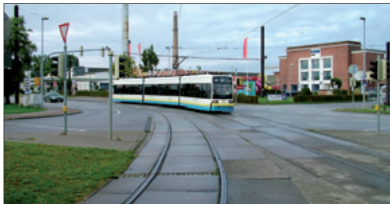
An der Wendeanlage am HELIOS Klinikum werden Mitte Oktober umfassende Instandsetzungsarbeiten durchgeführt Foto: NVS
