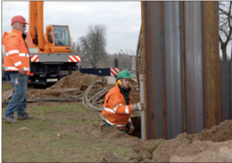
Passgenau: Michael Meier und Uwe Krause (re.) von der Meyer Union müssen darauf achten, dass der Kran die riesigen Wände für die Zulaufleitung zum Mischwasserspeicher am Nodrufer des Pfaffenteichs senkrecht ins Erdreich rammt Foto: max
