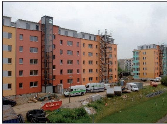
Blickfang: Mediterrane Farben, Aufzüge und das neue Staffelgeschoss in der Wuppertaler Straße Fotos: max
