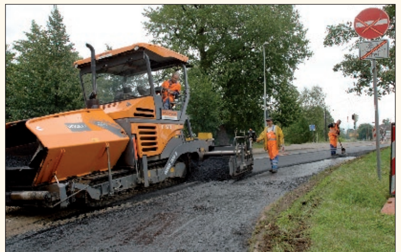
Mitarbeiter der Firma Matthäi aus Leezen erneuern im Auftrag der SDS den Straßenbelag in der Lennéstraße Foto: max
