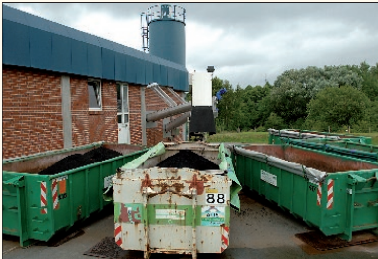
Gefüllter Klärschlammcontainer auf der Kläranlage
