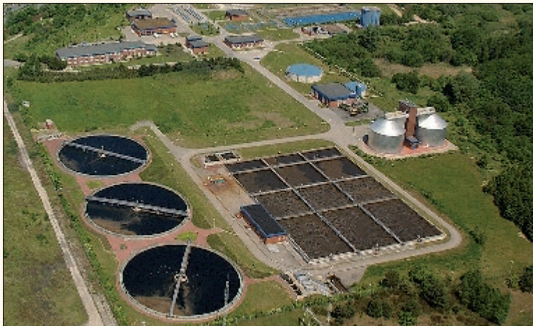
Umweltschonende Abwasserentsorgung: Die biologische Reinigungsstufe auf der Kläranlage in Schwerin Süd Fotos: max, privat
