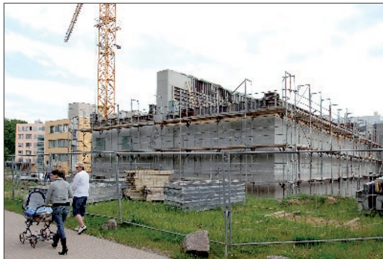
Endlich auf dem HELIOS-Gelände: Die neue Strahlenklinik ist jetzt im Bau
