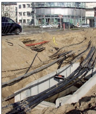
Aufwändige Tiefbauarbeiten: Für die neue Wendeschleife mussten zahlreiche Kabel umgelegt werden Fotos: max
