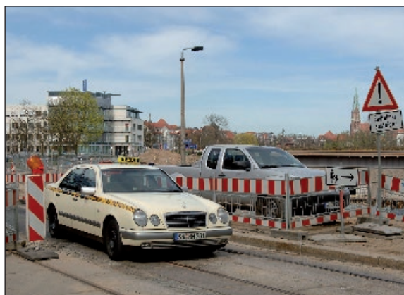
Bauarbeiten gehen in die heiße Phase: Vom 8. bis 11. Juni wird die Kreuzung Graf-Schack-Allee / J.-Stelling-Straße voll gesperrt
