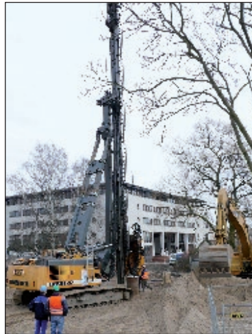
Mit schwerer Technik wird der Platz am Beutel gebaut Foto: BUGA
