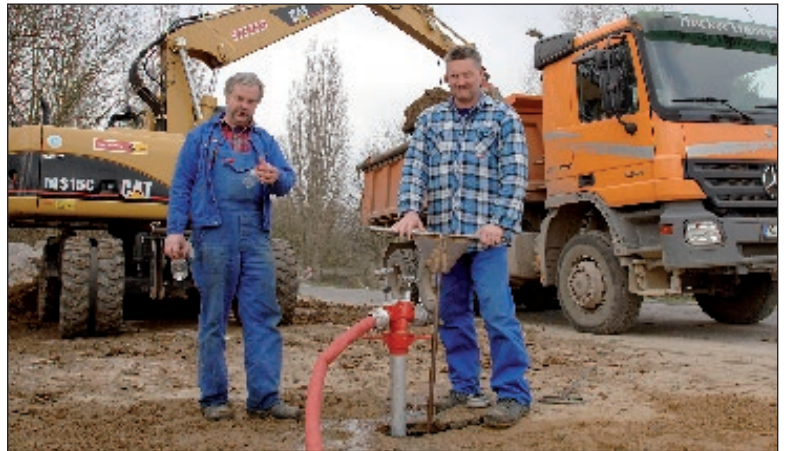
Neue Verlegung einer Wasserversorgungsleitung im Ziegelsee-graben: WAG-Mitarbeiter gewährleisten die sichere Wasserversorgung für den Stadtteil Schelfwerder Foto: max
