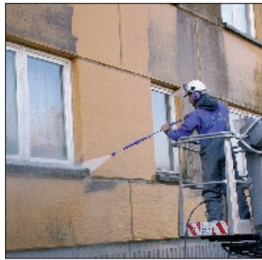
Stark verunreinigte Fassaden - die T5H reinigt größte Flächen effizient und preiswert
