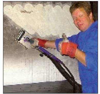
Brandschadensanierung - das Wandreini- gungsgerät im Einsatz Fotos: SAR/Falch
