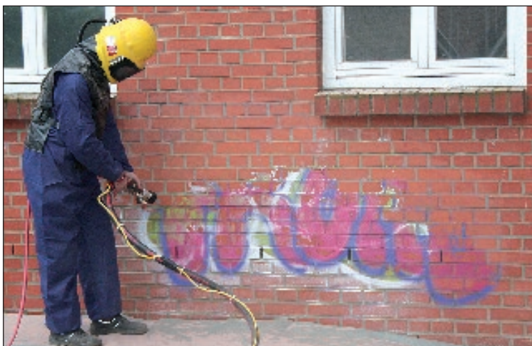
Mit der modernen Niederdruckstrahltechnik ist das „Graffiti-Ärgernis“ vieler Hausbesitzer an Klinkerfassaden problemlos und schnell behoben Foto: SAR
