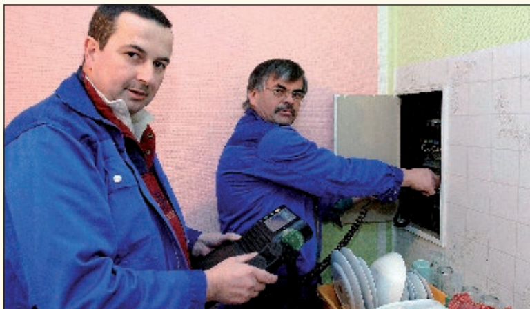
Die Elektroinstallateure der Firma Hasselbrink, Hartmut Burgmann und Manfred Sieverkrupp checken den Sicherungskasten in der Wohnküche Fotos: max
