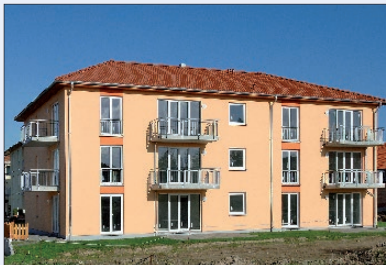
Am Blumenbrink 66 fühlen sich die NCC-Kunden bereits sehr wohl. Jetzt wird gleich nebenan ein zweites Mehrfamilienhaus nach diesem Vorbild gebaut. Foto: max
