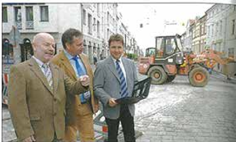
NVS-Aufsichtsratsmitglied Gert Rudolf informiert sich bei Lothar Matzkeit, Abteilungsleiter Technik, und Geschäftsführer Norbert Klatt (v.l.) über den Stand der Bauarbeiten. Foto: mvg
