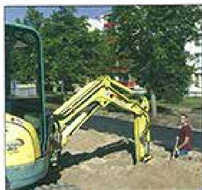
Mitarbeiter der Firma Ditting haben Kabelschächte im Innenhof aus
