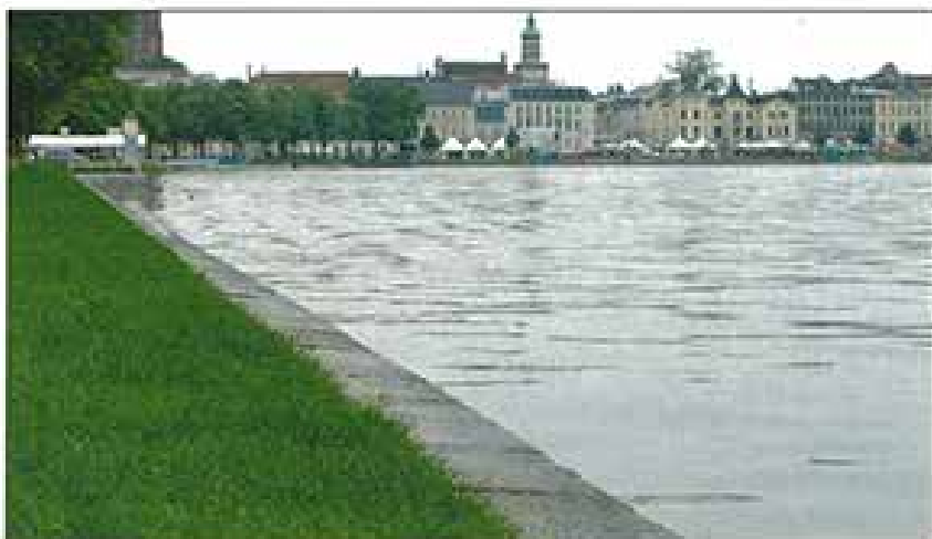
Fertig: Die neue Uferkante am Ostufer des Pfaffenteichs
