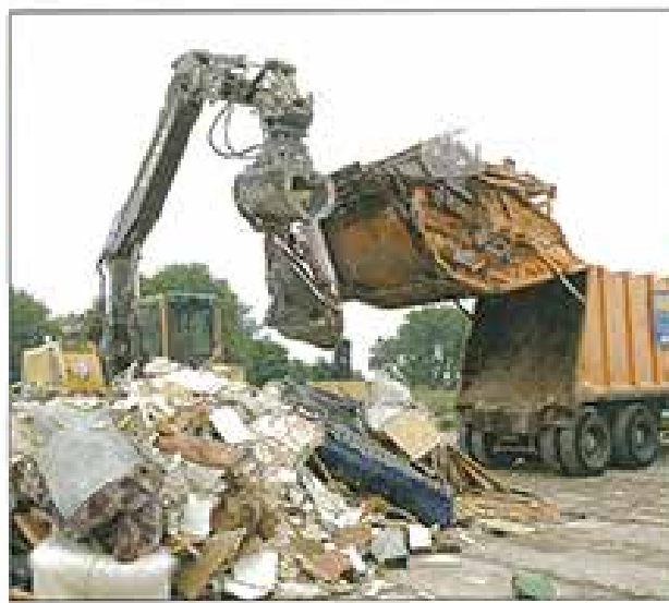
Auf dem Gelände der Firma Remex macht sich zunächst ein Bagger an die Grobsortierung
