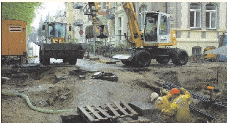
Die 110 Jahre alte Röntgenkammer wird grundlegend saniert und modernisiert
