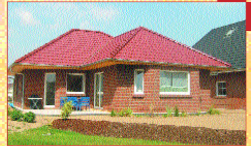
Lankow Wohnfläche: 88,08 m 2 schlüsselfertig 96.800,- €
