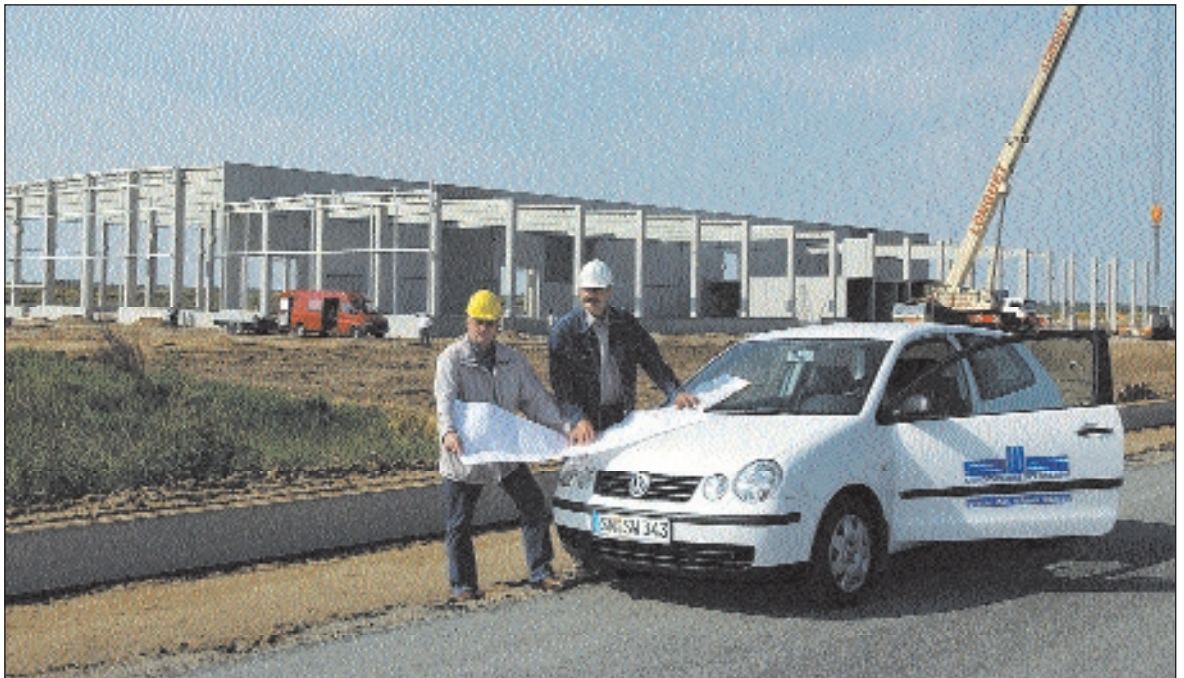
Baubetreuer Uwe Behrend (li.) und Sachbearbeiter Thomas Thiel vor dem neuen Produktionsgebäude der Flammaerotec Fotos: max
