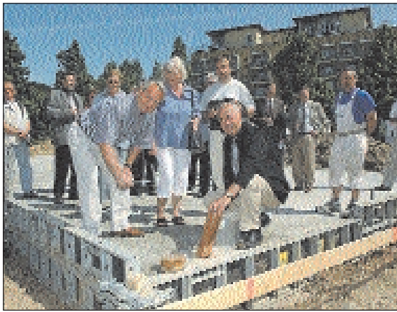
Wolfgang Heßler, Projektleiter der NCC, legte zusammen mit den Bauherren den Grundstein
