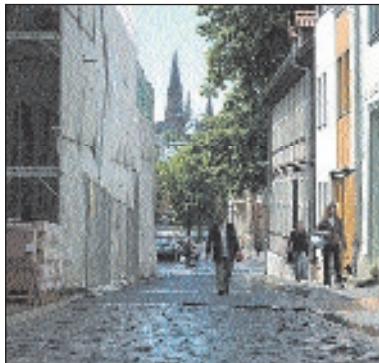
In der Körnerstraße beginnen die Arbeiten von SAE und Stadt am 25. Juli Foto: max
