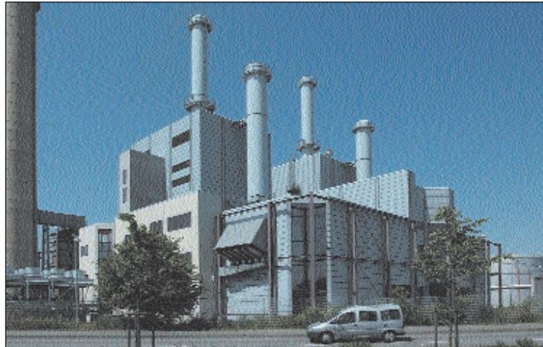
Im Heizwerk wird Strom und Heizenergie mit dem umweltfreundlichen Prinzip der Kraft-Wärme-Kopplung erzeugt
