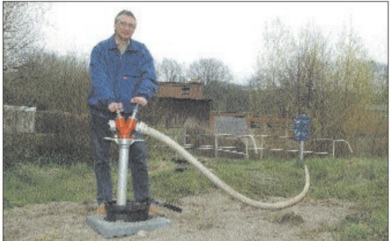
*Druckvoll: Mit einem Luft-Wasser-Gemisch spült Volkhardt Zillmann die vom Netz getrennte Leitung. Rückstände von Eisen und Mangan werden so restlos beseitigt Foto: max*
