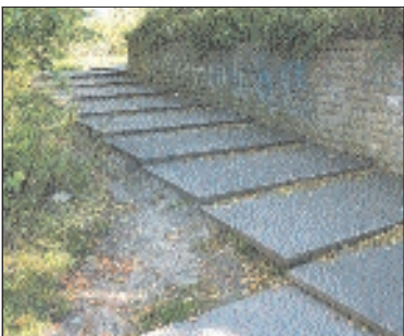
Schlechter Zustand: Die Rampe von der Lomonossow- zur Mendelejewstraße
