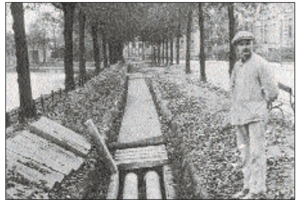
Mit dem Kühlwasser der Dieselmotoren im E-Werk wurden über Leitungen Häuser in der August-Bebel-Straße mit Wärme versorgt
