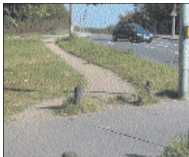
Auch der Fuß- und Radweg an der Hamburger Allee wird erneuert
