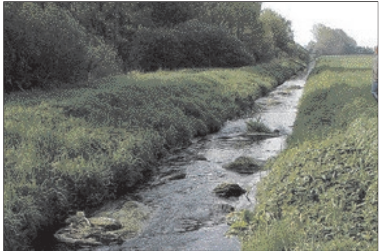
Nicht das gesamte gereinigte Abwasser gelangt über solche Gräben, hier zwischen Sülstorf und Alt Zachun, in die Sude. Ein Teil wird zum Salzstock nach Kraak gepumpt Foto: SAE
