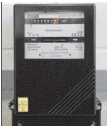
Über 70.400 dieser Elektrizitätszähler gibt es in Schwerin. Die regelmäßige Überprüfung sichert eine lange Lebensdauer
