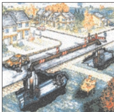
Mit dem Hamburger Heber wird ein auszu-tauschendes Kanalstück „überbrückt“ Grafik: Hamburger Heber Vertriebs GmbH
